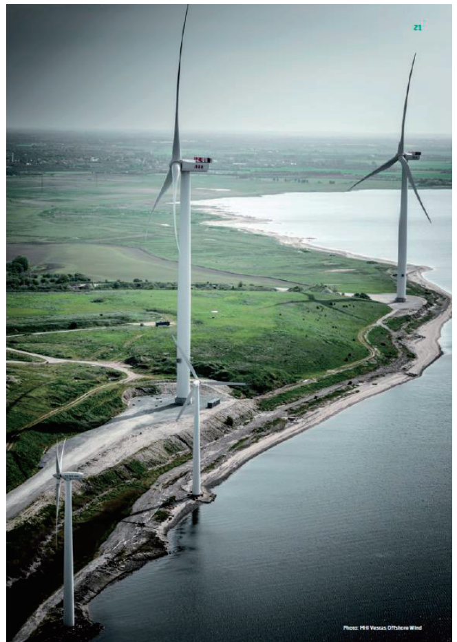
写真1 デンマーク・ウスタイル(Østerild)に設置されている風車の風景
